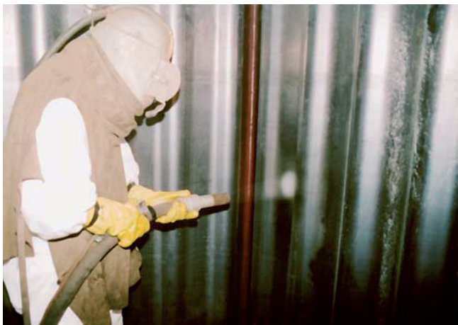
So wird ein Tank gesandstrahlt: Die Stahloberfläche wird von Rost befreit und aufgeraut, damit die Beschichtung später optimal haftet.
