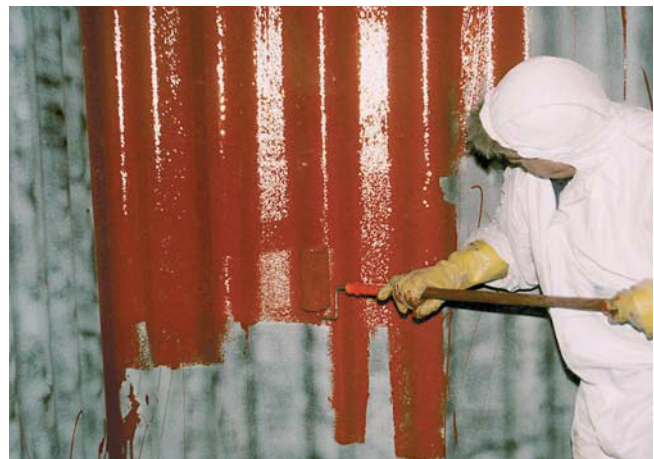
Unser Mitarbeiter trägt von Hand die Beschichtung auf – gründlicher Schutz für jahrelange Sicherheit. Jetzt hat der Rost keine Chance mehr.
